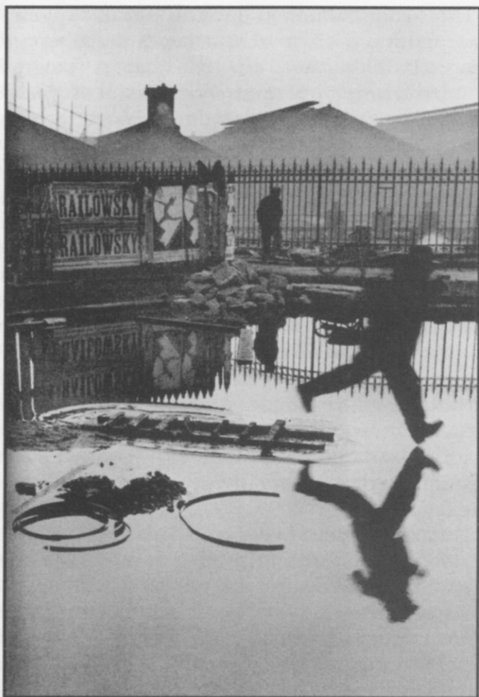
Detrás da Estação de Saint-Lazare, Paris, 1932
